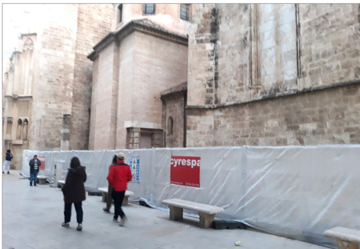
Ya se encuentra en obras la terminación del espacio en la fachada de la Catedral de la calle del Micalet, que permitirá proteger los muros contra humedades y embellecer el entorno.
